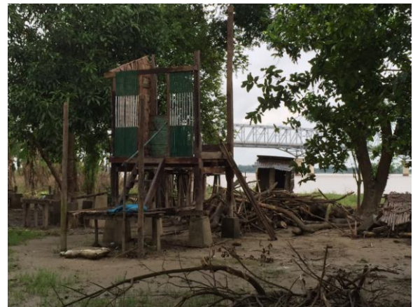
上流から流木が散乱し建物も壊れている
