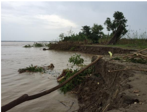
地面が崩落した場所
