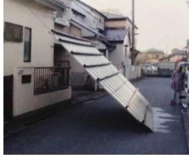
② 吹き飛んだトタン屋根が約30m飛ばされる。 (画像提供:現地当社サポーター)
