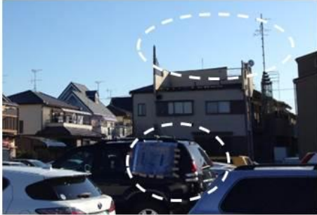
① 飛散物により窓ガラスが割れた乗用車(手前)と屋上のトタン屋根が吹き飛んだ家屋
