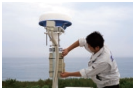
TSUNAMIレーダー設置の様子
