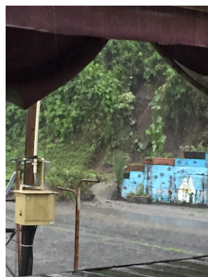
7/6 8:21 大分県日田市大字有田 自宅前土砂崩れ道路半分埋もれた。
