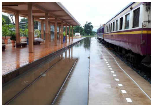
大雨の影響でタイ北部の Den Chai 駅が冠水する様子
